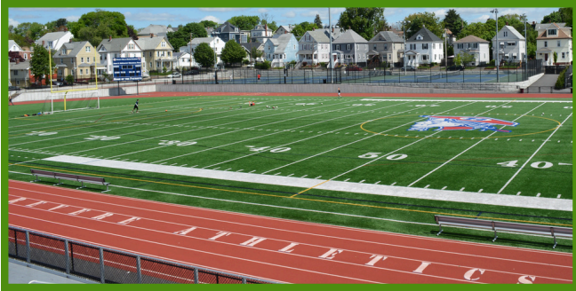
Harry Della Russo Stadium: Park Ave
